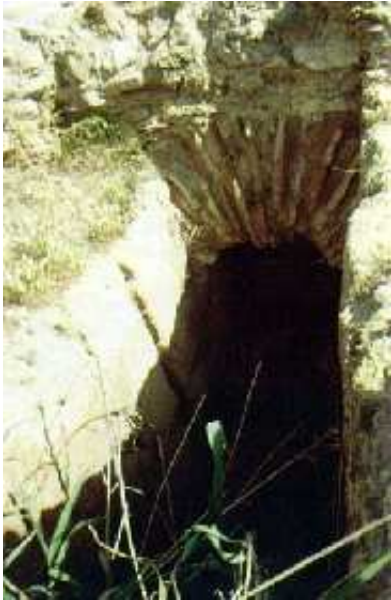
Inicio de la galería qanat de Fuente Grande (D. Ortiz, 1989)
