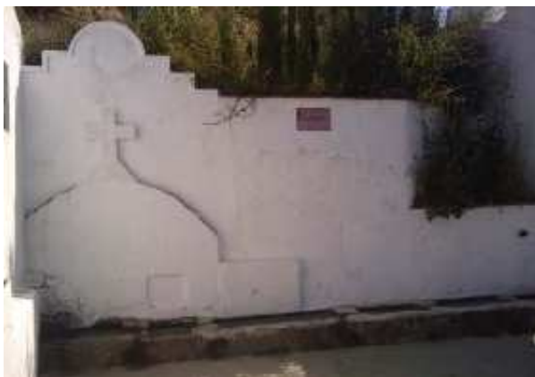
Fuente-lavadero de Benarrabá (Centro Guadalinfo Benarrabá, mayo 2010)
