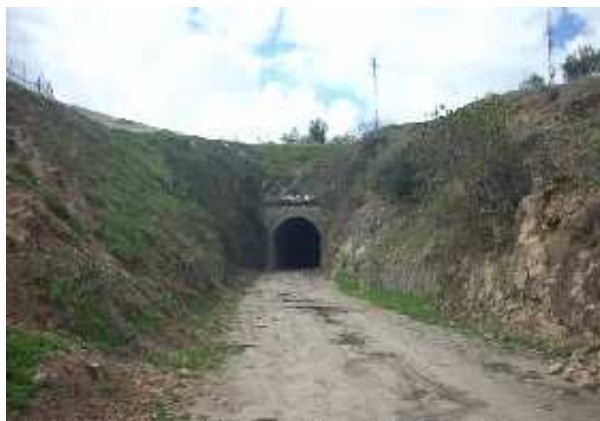
Entrada del túnel (M. Rubio Torres, abril 2012)
