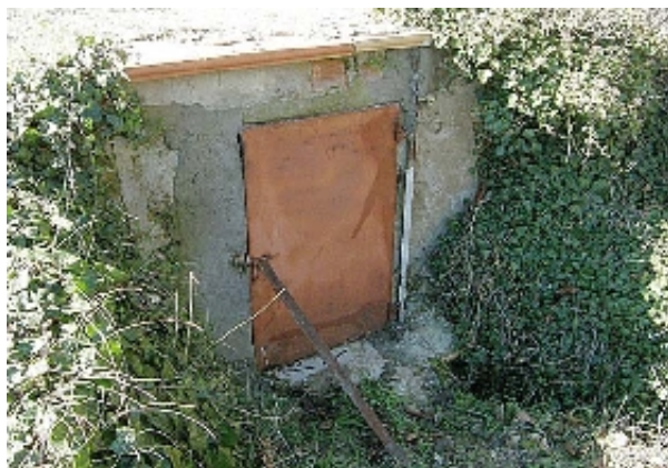
Manantial de Huarte, caseta de protección (A. Vela Torres, febrero 2012)
