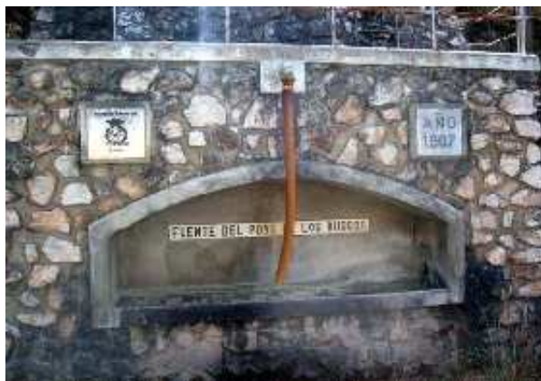
Fuente del Poyo de los Burgos (J. D. Cano Cavanillas, marzo 2005)
