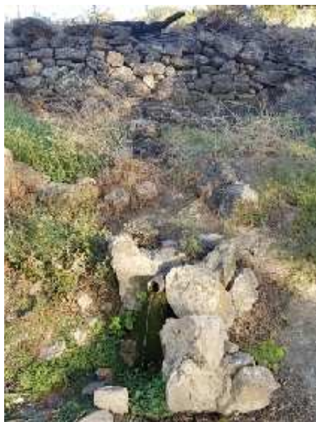
Fuente y muro de protección del camino al fondo (I. Palma, agosto 2020)
