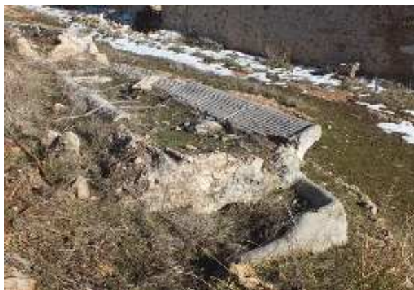
Lavadero de Los Goldines (J. D. Cano Cavanillas, febrero 2012)
