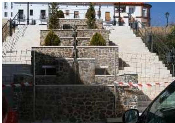
Cascadas artificiales (J. L. Macias, febrero 2012)
