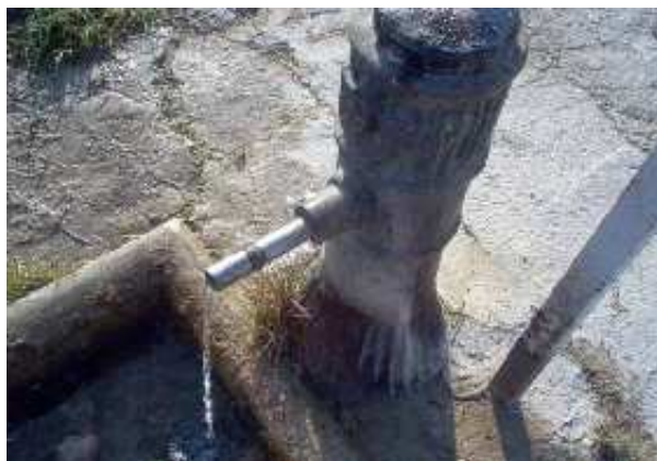
Fuente del Pilarillo (A. Civantos Moral, noviembre 2011)
