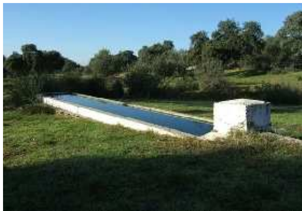
Fuente de Los Majadales Bajos, vista general (F. Cuesta López, diciembre 2011)
