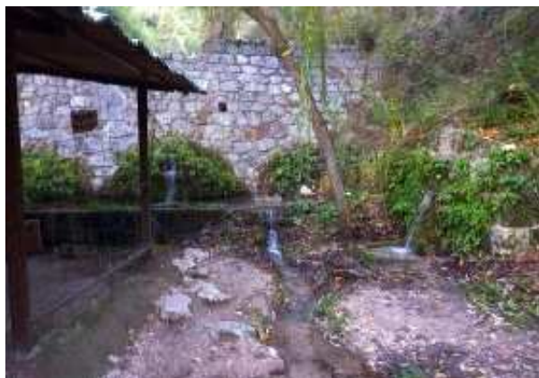
Fuente del Empalme del Valle (J. D. Cano Cavanillas, noviembre 2011)
