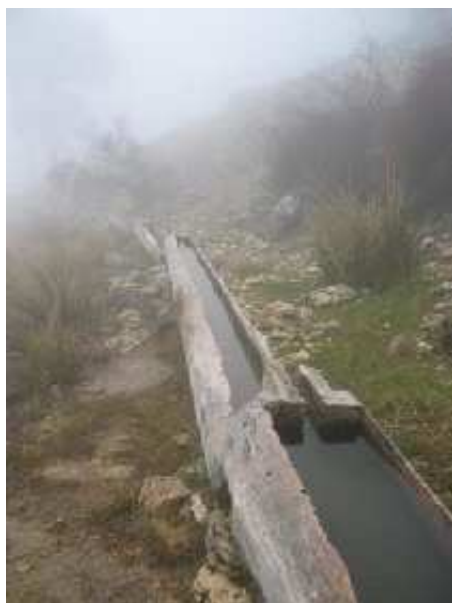
Tornajos del Collado de las Hoyas (L. Cano Cavanillas, enero 2004)
