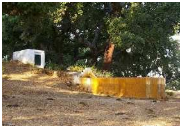
Vista de la fuente y la caseta de toma (J.M. Amarillo Vargas, octubre 2011)
