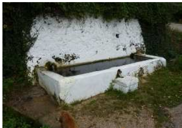
Fuente y lavadero de la Hueta (J. D. Cano Cavanillas, octubre 2010)
