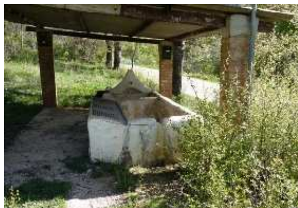
Lavaderos en los Prados de la Presa (J. D. Cano Cavanillas, abril 2011)
