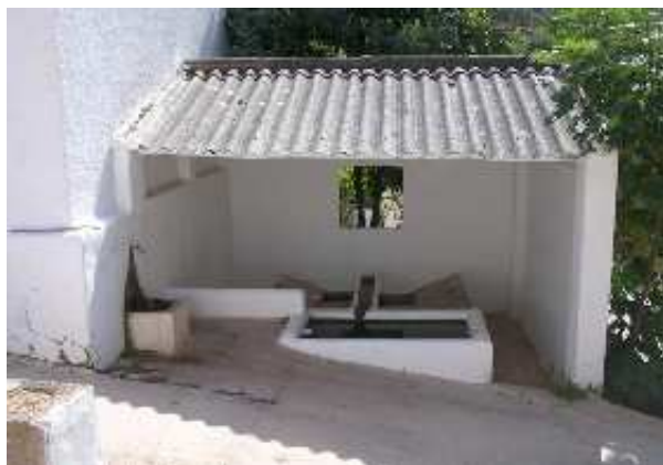
Fuente y lavadero del Batán (D. Oya Muñoz, septiembre 2011)
