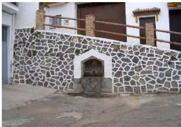
Fuente de la calle Cortadero (S. Rodríguez, julio 2011)
