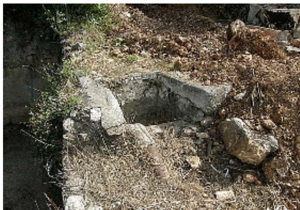
Pileta donde vertía el manantial (A. Vela Torres, junio 2011)
