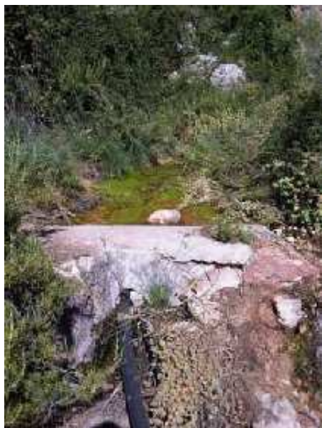
Nacimiento de Arroyo Santo, captación para riego (J.D. Cano Cavanillas, julio 2011)
