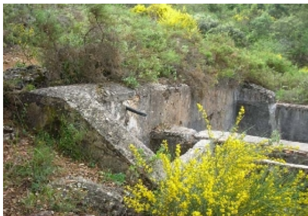
Alberca del Carbonero, muro de contención (F. Cuesta, mayo 2011)
