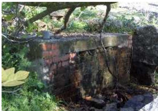
Fuente de la Fuentezuela, caseta de protección (S. Rodríguez, abril 2011)
