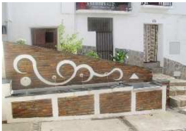
Fuente de Colón remodelada en 2010 (W. Gómez Ortega, noviembre 2010)
