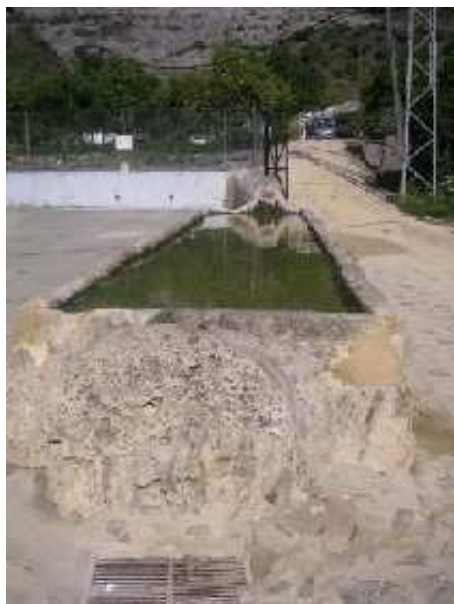
Pilar del Nacimiento o Pilar del Molino Ancho (J.A. González, abril 2005)
