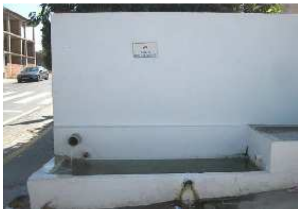
Fuente de la Carretera (R. Martín, septiembre 2010)
