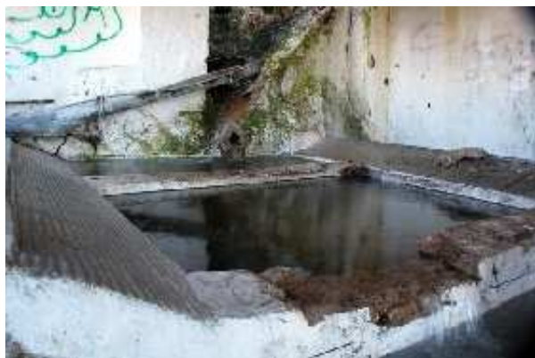
Lavadero del Chopo, vista parcial (F. Serrano García, abril 2010)
