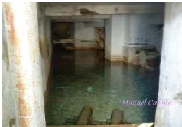
Interior del Tempete (M. Cabello, enero 2000)
