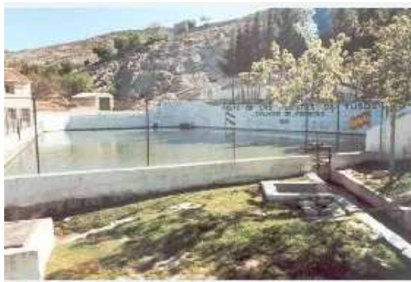
Manantial de los Tubos (T. Peinado)
