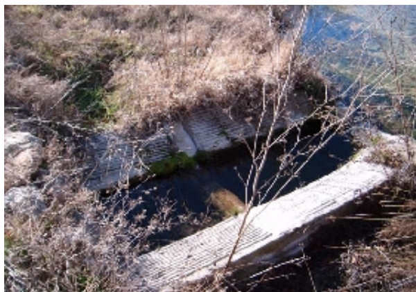
Fuente Alta, lavadero (Club Deportivo Nueva Aventura de Oria, enero 2011)
