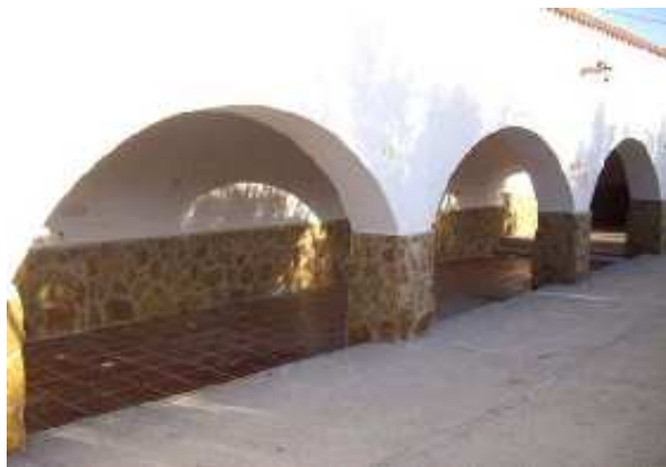
Fuente-lavadero de Alhabia (A. Benavides, enero 2011)
