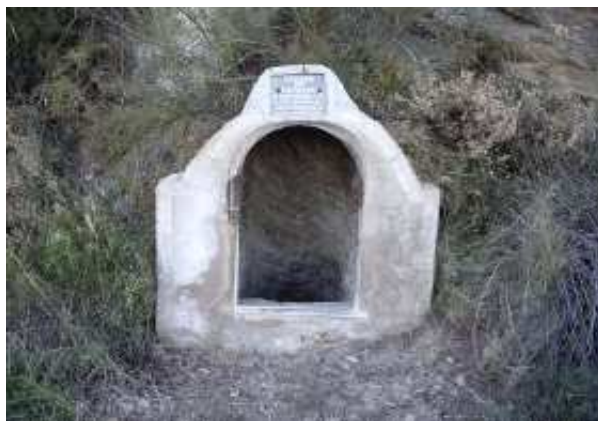
Fuente del Socorro (A. Benavides, diciembre 2010)
