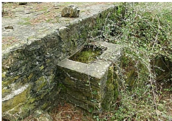
Pilar del Arroyo de los Frailes (A. Vela Torres, diciembre 2010)
