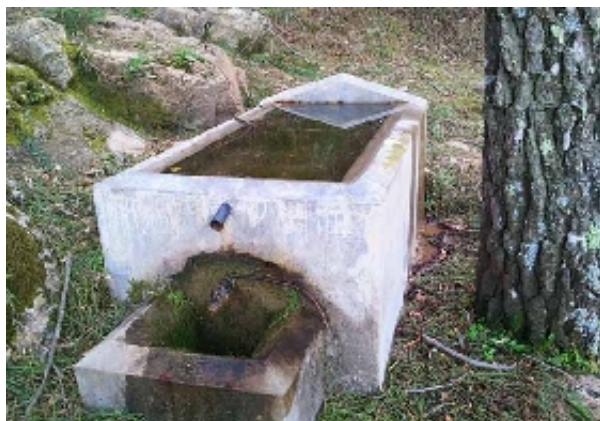
Nacimiento del Peñón del Granito, pilar - abrevadero (D. Barrera, diciembre 2010)
