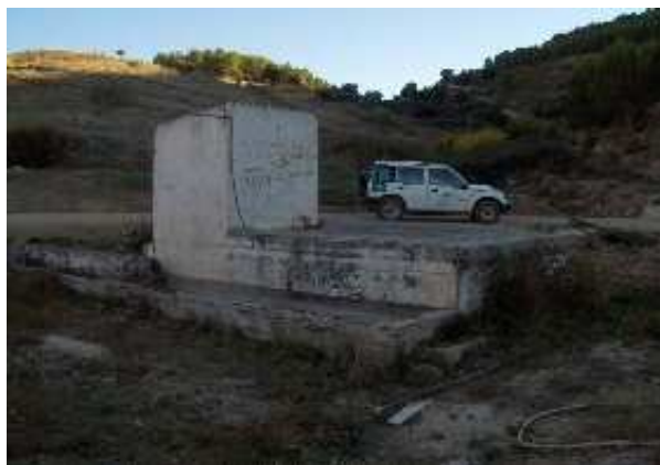
Abrevadero del Madroño (S. Rodríguez, noviembre 2010)
