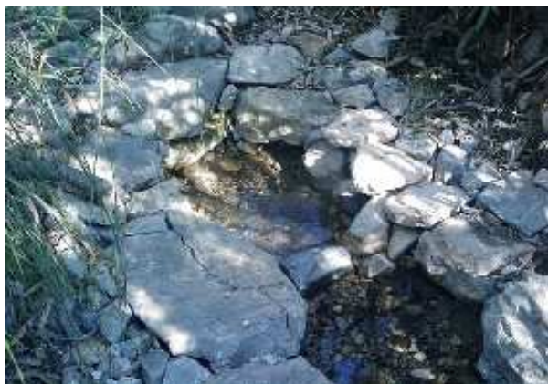
Fuente del Cañuelo (J. M. Lomas, noviembre 2010)
