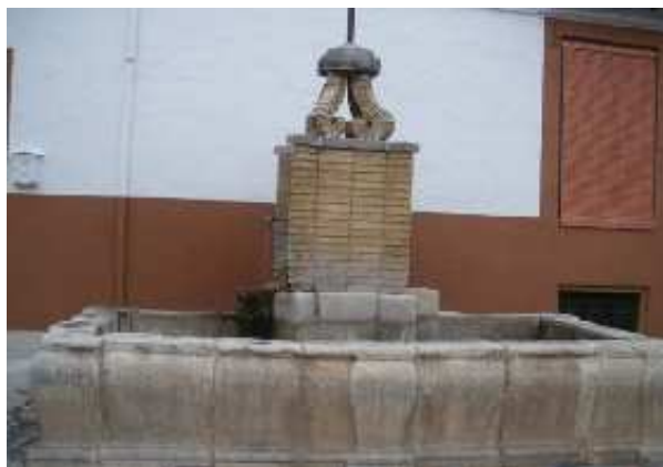
Pilar de la Laguna (J.A. Palomino, noviembre 2010)
