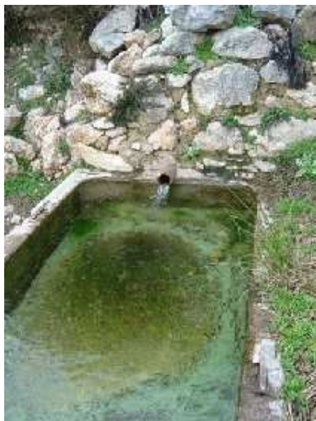
Pila del Puerto (D. Polo, septiembre 2010)
