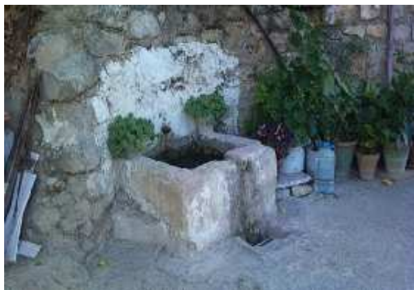
Fuente de la Calle Alta, vista lateral (F. Cuesta, septiembre 2010)
