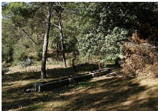
Abrevadero del Lagar de Don Ventura (A. Vela Torres, octubre 2010)
