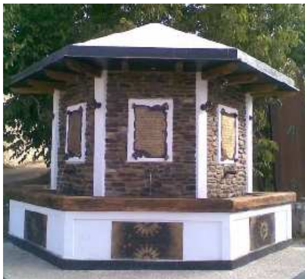
Fuente de las Cruces de nueva construcción (F. Prats, septiembre 2010)
