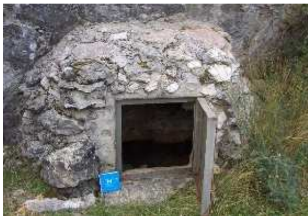
Fuente del Cerro de la Yedra (S. Rodríguez, octubre 2010)
