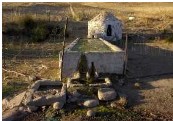
Fuente - abrevadero del Cortijo Las Angosturas (S. Rodríguez, septiembre 2010)
