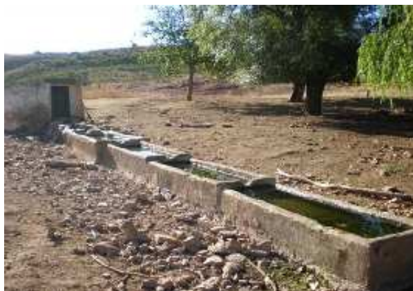
Pozo de la Añoreta (A. Vela Torres, septiembre 2008)
