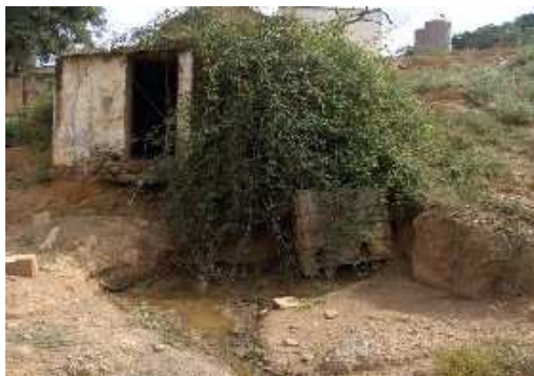
Fuente - aljibe de Las Amarillas (S. Rodríguez, agosto 2010)
