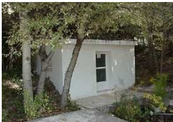
Manantial Capilla II, caseta de protección (F. Suarez, 2005)
