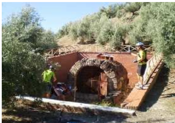
Fuente del Aljibe, vista general y muro protector (F. Cuesta, agosto 2010)
