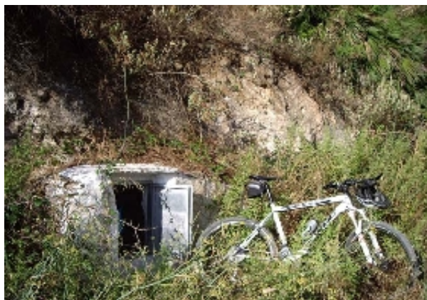
Fuente de la Solana, caseta de protección (F. Utrera, agosto 2010)
