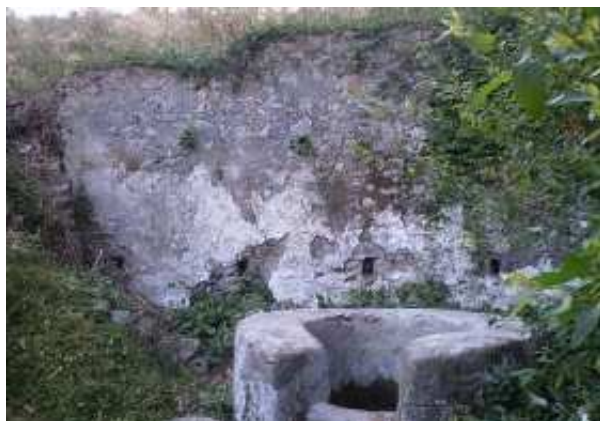
Fuente de la Cea, pozo de recogida de agua (J. Márquez, agosto 2010)
