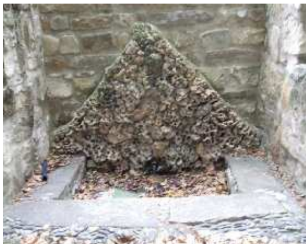
Fuente de Torrequebrada (M. J. Madrid, junio 2010)
