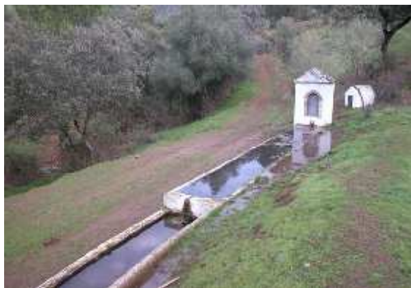
Fuente de Barazona (R. Córdoba, diciembre 2010)
