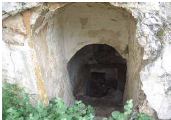
Toma de agua de Carratraca (R. Quesada Herrera, mayo 2010)
